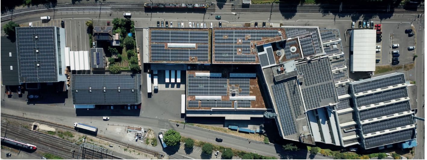
Müller Packaging (Bild: Standort Münchenstein) hat auf ihren Produktionshallen flächendeckend Photovoltaikanlagen installiert.
